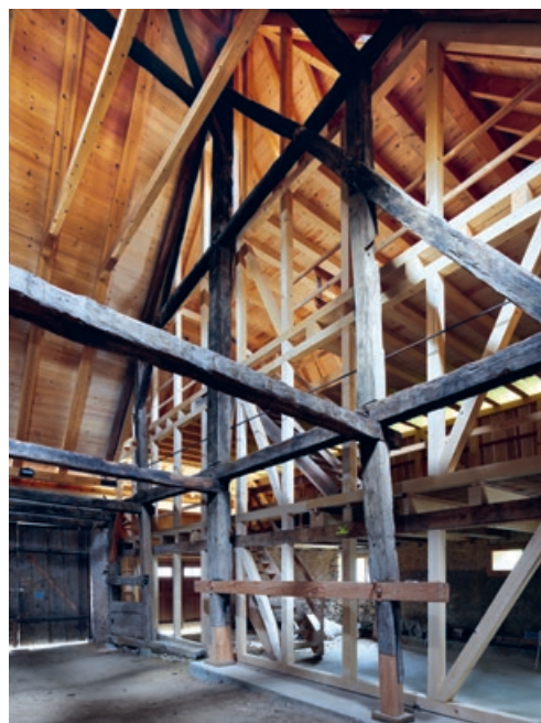
7.6 Tenne mit Blick in Richtung Scheunenwohnung Hinter dem restaurierten Querbund von 1555/56 bildet eine neu errichtete Fachwerkwand einen Abschluss zur später ausbaubaren Scheunenwohnung.
