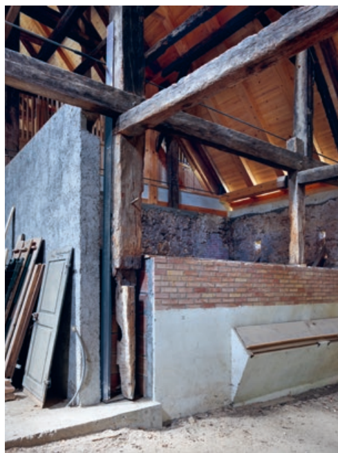
7.7 Reparaturdetail Hochfirstständer Der Zahn der Zeit hat an diesem Hochfirstständer genagt.
