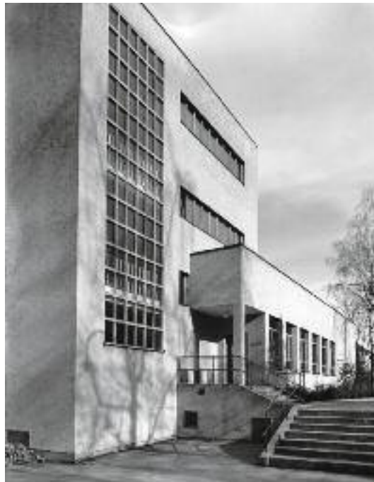
Abb. 70 Luzern, Schulanlage Dula, Schulhaus. Ansicht vom Unterstand zwischen Schulhaus und der Turnhalle aus auf die Fassade des Schulhofs. Der Schulhof wird unter den Schulhausstrakt erweitert, wo sich über den Stützen aus Granit ein überdachter Pausenhof bildet. Aufnahme von Otto Pfeifer, gegen Ende der 1930er-Jahre.
