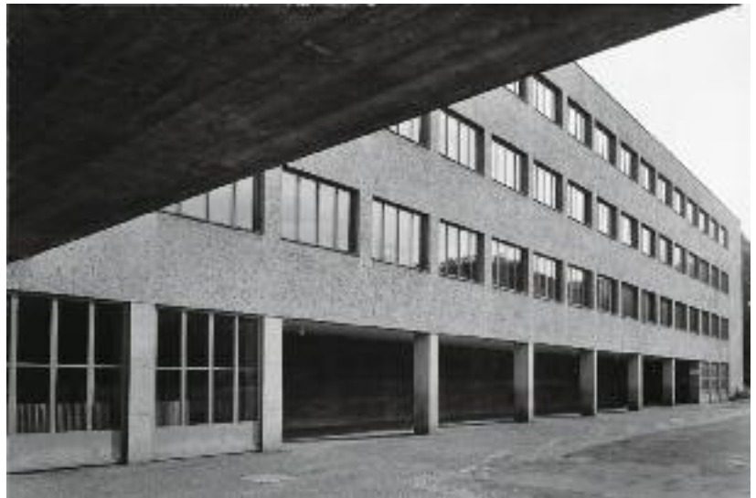
Abb. 70 Luzern, Schulanlage Dula, Schulhaus. Ansicht vom Unterstand zwischen Schulhaus und der Turnhalle aus auf die Fassade des Schulhofs. Der Schulhof wird unter den Schulhausstrakt erweitert, wo sich über den Stützen aus Granit ein überdachter Pausenhof bildet. Aufnahme von Otto Pfeifer, gegen Ende der 1930er-Jahre.
