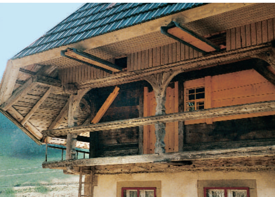
4 Die reparierten Stellen der Bohlenwände werden sich mit der Zeit farblich an den Altbestand angleichen. Die horizontal über dem Holzgeschoss herausstehenden Dielen werden „Schübe“ genannt. Sie sind Teil der Decke des Wohnteils und besitzen eine konische Form. Entstehen durch das Trocknen des Holzes Fugen in der Decke, werden diese Schübe wie Keile eingetrieben. Dadurch werden die benachbarten Dielen wieder zusammengeschieben und die Klüfte schließen sich.
