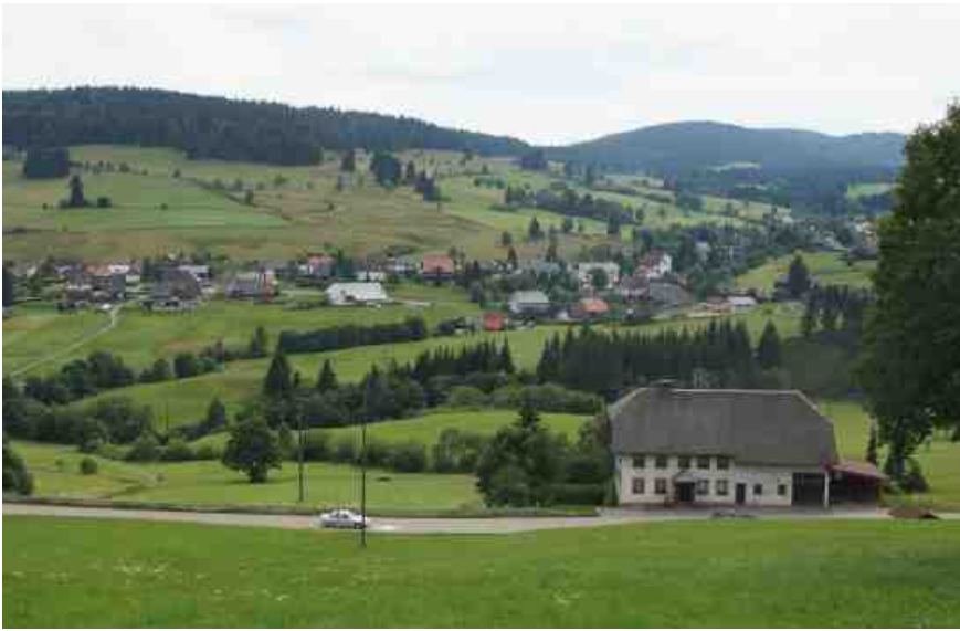
Bild oben: Ein wesentliches Element der Siedlungsstruktur in Bernau ist die Lage der Bebauung am Hang, während die Talsohle von Bebauung weitgehend freigehalten ist. Der Blick über das Hochtal hinweg bestimmt das Ortsbild, die älteren Schwarzwaldhöfe mit meist grauen Dächern sind gut zu erkennen.
