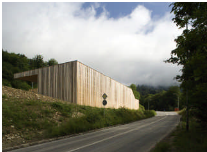
Holzpreis Schweiz – Prix Lignum 2009: Hauptpreis Region Mitte Forstwerkhof der Burgergemeinde Biel BE, 2007. Architektur: Bauzeit Architekten, Biel
